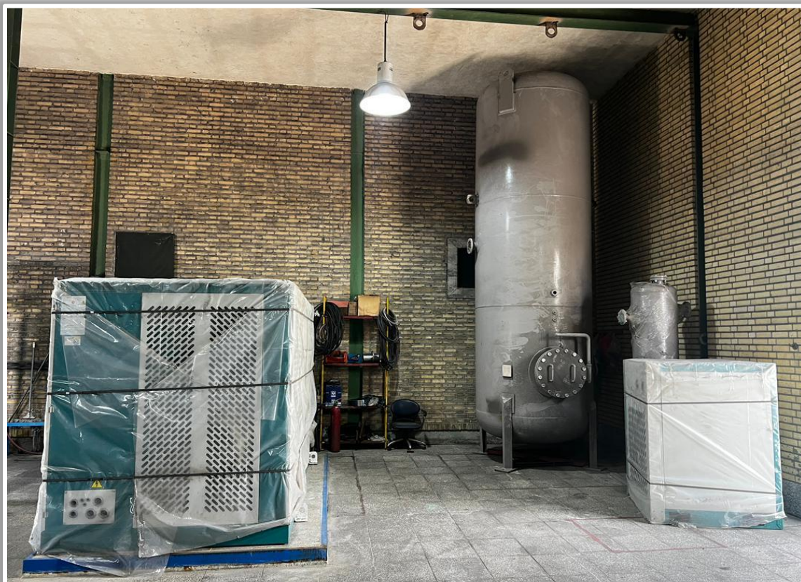
نصب اولیه کمپرسور و مخزن هوای فشرده
