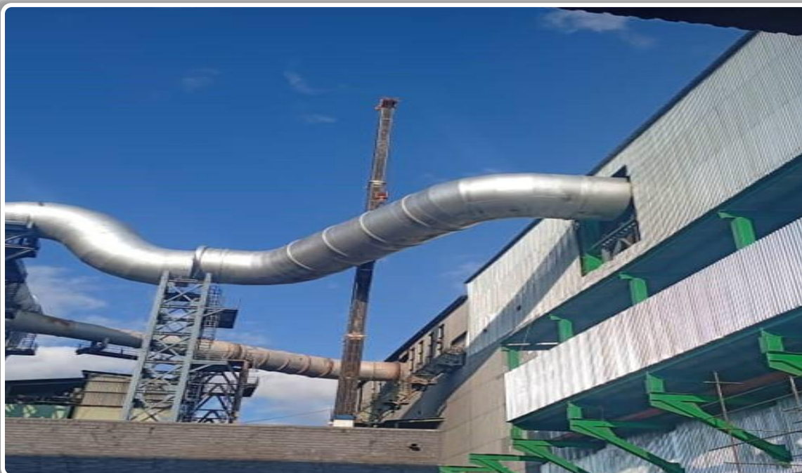
نصب لوله های رابط و سیکلون غبارگیر
