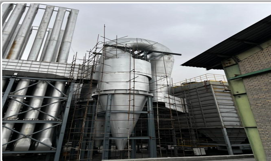
نصب لوله های رابط و سیکلون غبارگیر
