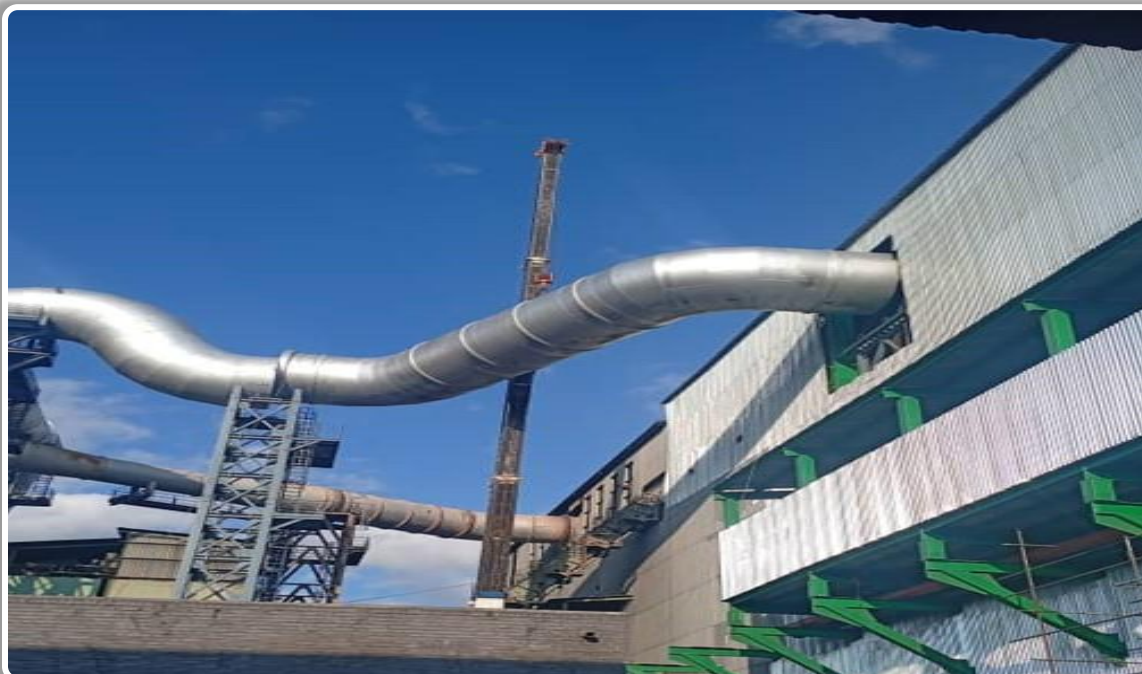
نصب لوله های رابط و سیکلون غبارگیر
