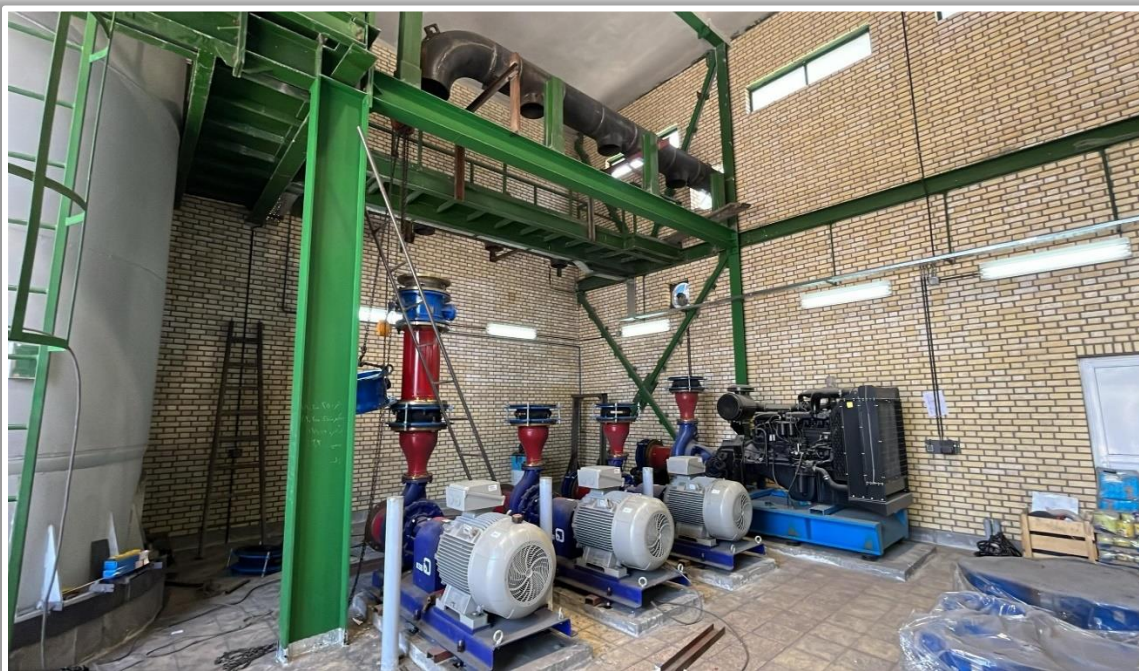
شروع عملیات نصب پمپ ها و اتصالات سیستم آب مدار بسته
